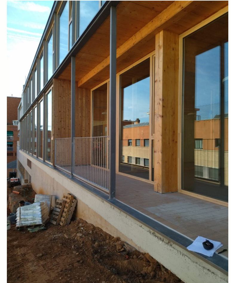
Estructura Metálica Escola Bressol Municipal Teixonera . Barcelona
