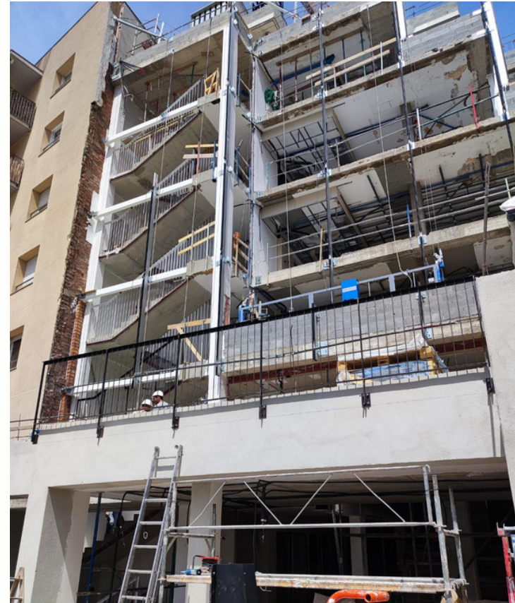
Estructura y cerrajería colegio The British School . Barcelona
