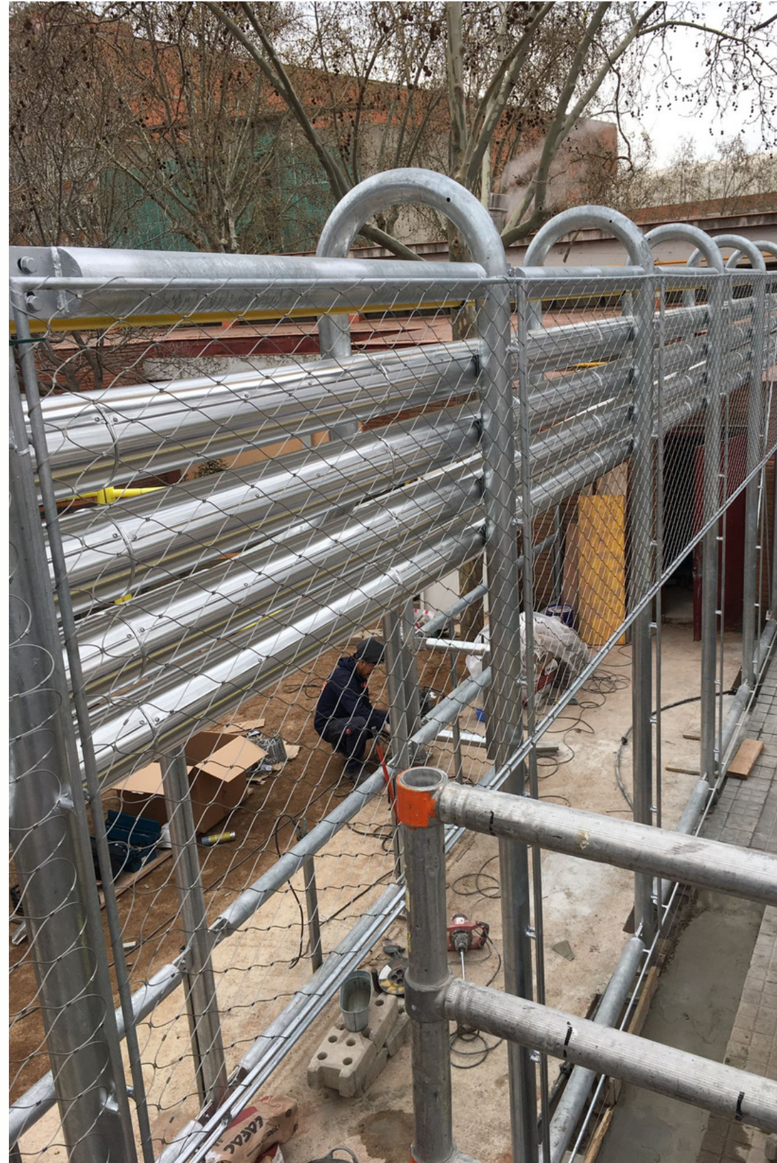
Estructura Metálica Guardería El Caminet del Besòs. Barcelona
