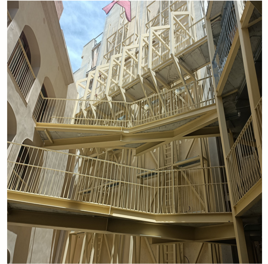
Estructura Metálica en edificio La Carbonería . Barcelona
