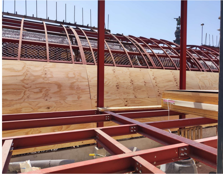
Rehabilitación estructura Metálica en Portal de la Pau. Barcelona
