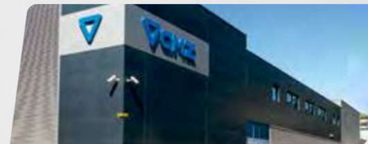
Planta de montaje de tornos CNC 5.500 m2 | Zaldibar – Spain
