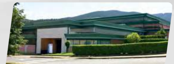
Planta de mecanizado 970 m2 | Elorrio – Spain
