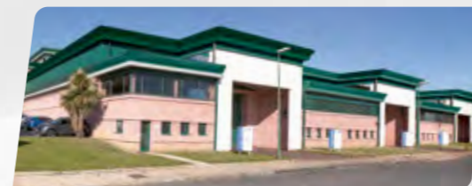
Planta de mecanizado 4.900 m2 | Elorrio – Spain
