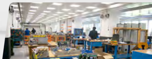
Planta de montaje de armarios eléctricos 1.250 m2 | Zaldibar – Spain
