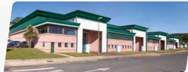
Planta de mecanizado 4.900 m2 | Elorrio – Spain
