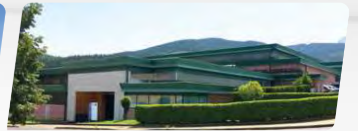
Planta de mecanizado 970 m2 | Elorrio – Spain
