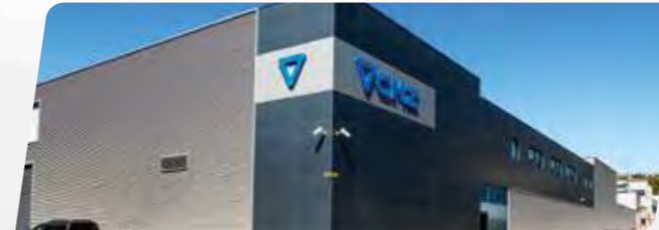
Planta de montaje de tornos CNC 5.500 m2 | Zaldibar – Spain
